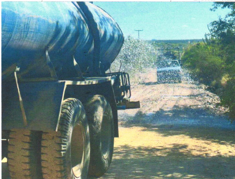
FOTO 03 - EXECUÇÃO E COMPACTAÇÃO DE ATERRO COM SOLO PREDOMINANTEMENTE ARGILOSO - EXCLUSIVE SOLO, ESCAVAÇÃO, CARGA E TRANSPORTE. AF_11/2019
