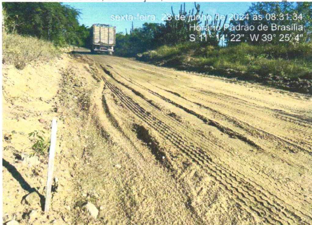
FOTO 06 - EXECUÇÃO E COMPACTAÇÃO DE BASE E OU SUB BASE PARA PAVIMENTAÇÃO DE SOLO ESTABILIZADO GRANULOMETRICAMENTE SEM MISTURA DE SOLOS - EXCLUSIVE SOLO, ESCAVAÇÃO, CARGA E TRANSPORTE. AF_11/2023
