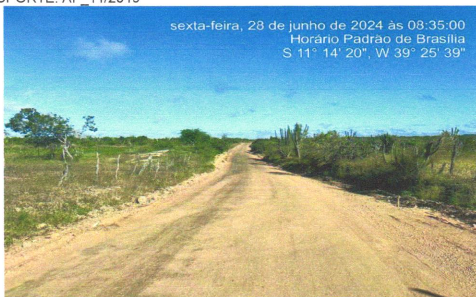
FOTO 02- EXECUÇÃO E COMPACTAÇÃO DE ATERRO COM SOLO PREDOMINANTEMENTE ARGILOSO - EXCLUSIVE SOLO, ESCAVAÇÃO, CARGA E TRANSPORTE. AF_11/2019
