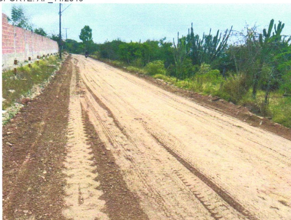
FOTO 04 - EXECUÇÃO E COMPACTAÇÃO DE ATERRO COM SOLO PREDOMINANTEMENTE ARGILOSO - EXCLUSIVE SOLO, ESCAVAÇÃO, CARGA E TRANSPORTE. AF_11/2019
