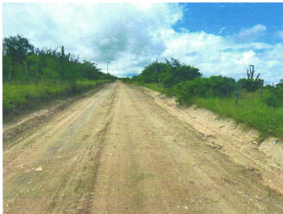
FOTO 01- EXECUÇÃO E COMPACTAÇÃO DE ATERRO COM SOLO PREDOMINANTEMENTE ARGILOSO - EXCLUSIVE SOLO, ESCAVAÇÃO, CARGA E TRANSPORTE. AF_11/2019
